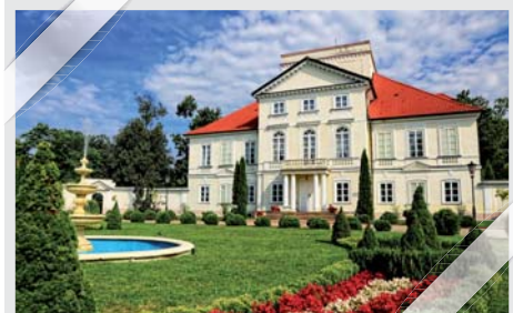
Elewacja południowa Pałacu – sierpień 2014
