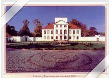
Elewacja południowa Pałacu – wrzesień 2001
